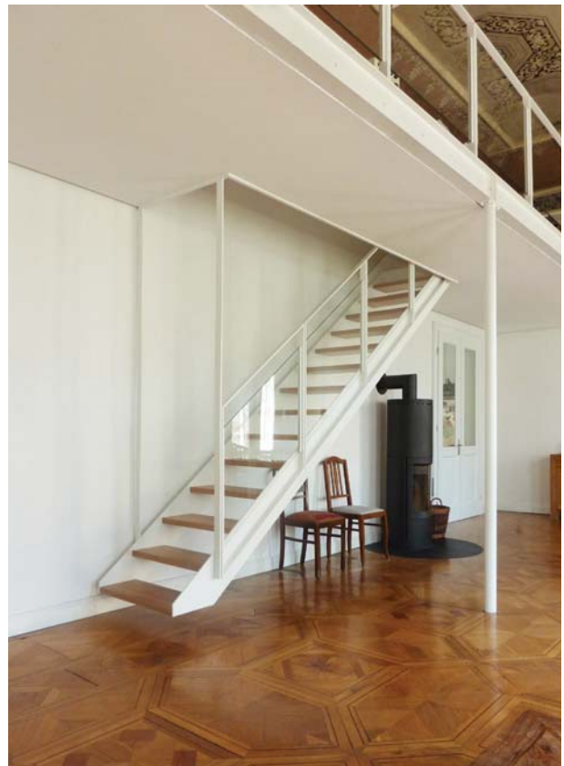
Die Treppe ist abgehängt, um das Parkett mit Intarsien nicht zu beschädigen
