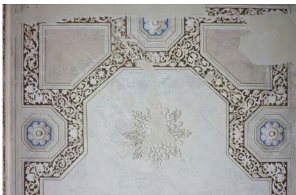
... wurden konserviert und stellenweise restauriert
