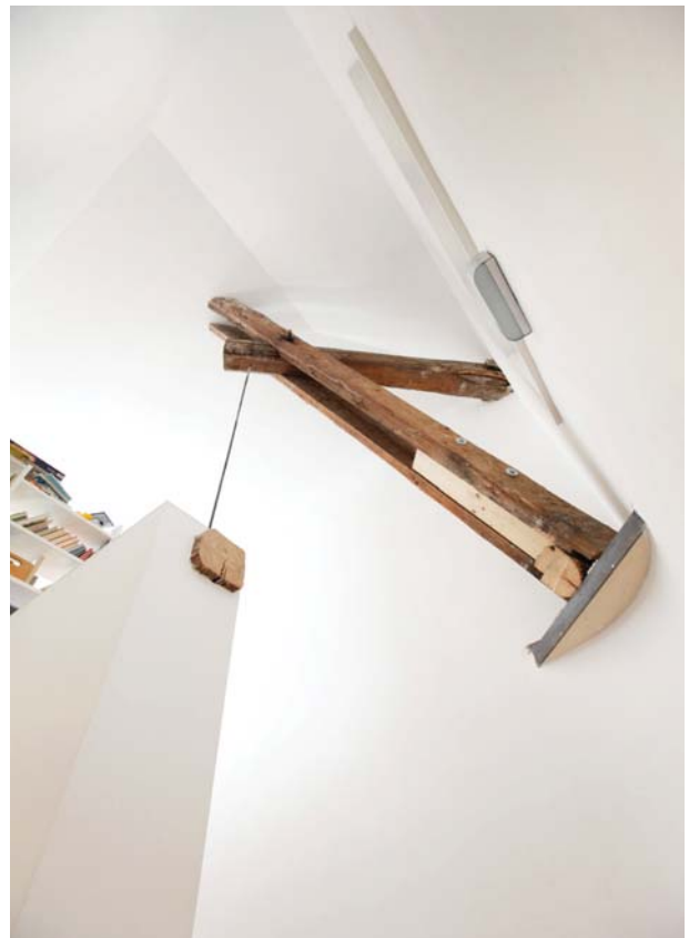
Abfangung der Geschossdecke im Bereich der bestehenden Holzterre
