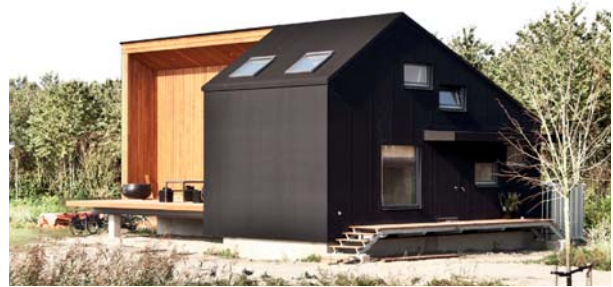
zweigeschossiger Gebäudeteil mit Satteldach und eingeschossiger Gebäudeteil mit Pultdach
