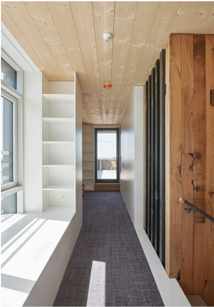
Dachgeschoss: Möbel und Innenwände aus gebrauchten Messebauplatten, Absturzsicherung aus gebrauchtem Stahl, Teppich aus Recyclinggarn
