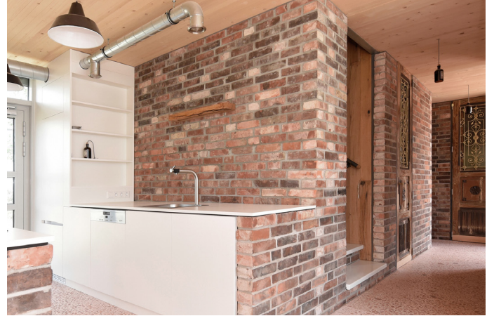
Innenwände aus Abbruchziegeln, Terrazzo "Opus Signium" mit Ziegelsplitt-zuschlag, historische Bauernhaustür umgebaut zu Innentüren
