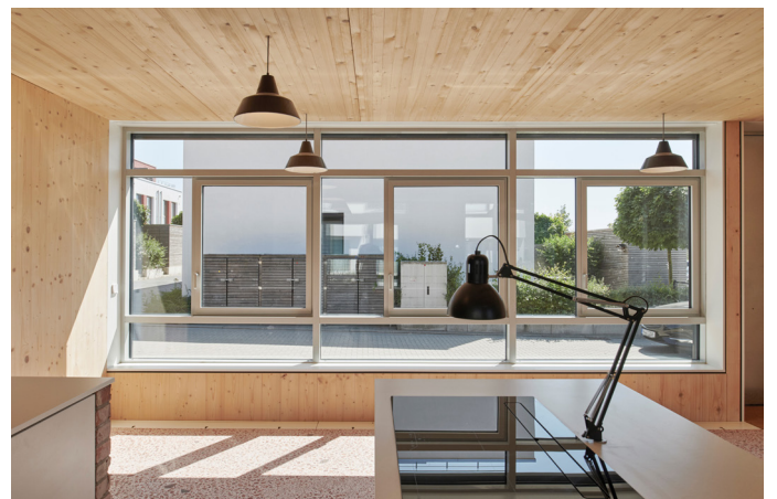
Küche: Massivholzrohbau, gebrauchte Aluminium-Fensterelemente, Laibungsbretter aus alten Messebauplatten, gebrauchte Innenausstattungen
