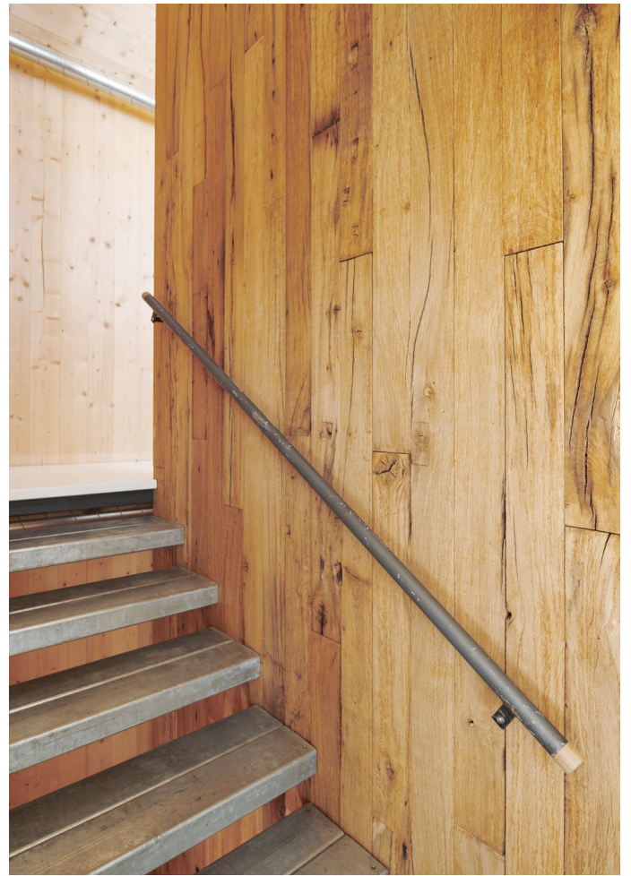
Treppenhaus: Brettstapelwand aus historischer Eiche, Treppe, Podestkonstruktion und Handlauf aus gebrauchten Stahlbauteilen
