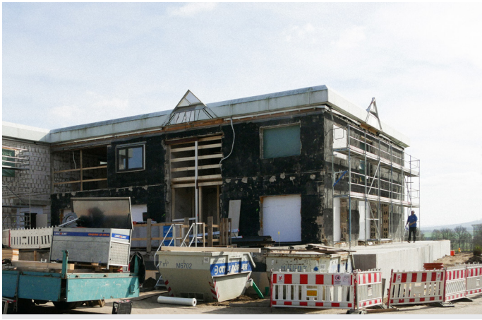
Baustelle Hofseite März 2026
