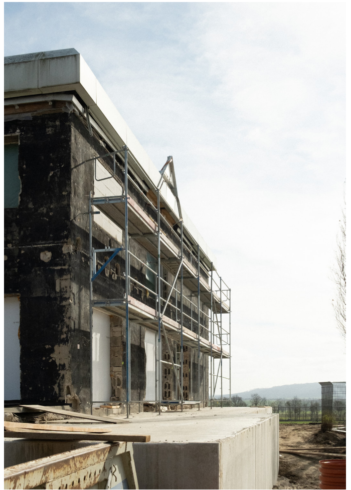
Baustelle Westseite März 2026
