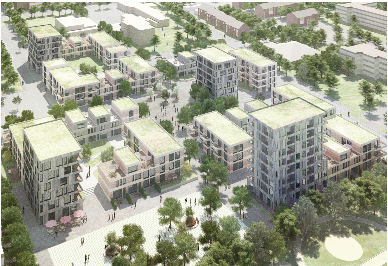
Überflug mit Blick auf die unterschiedlichen Gebäudetypen und die Platzfolge
