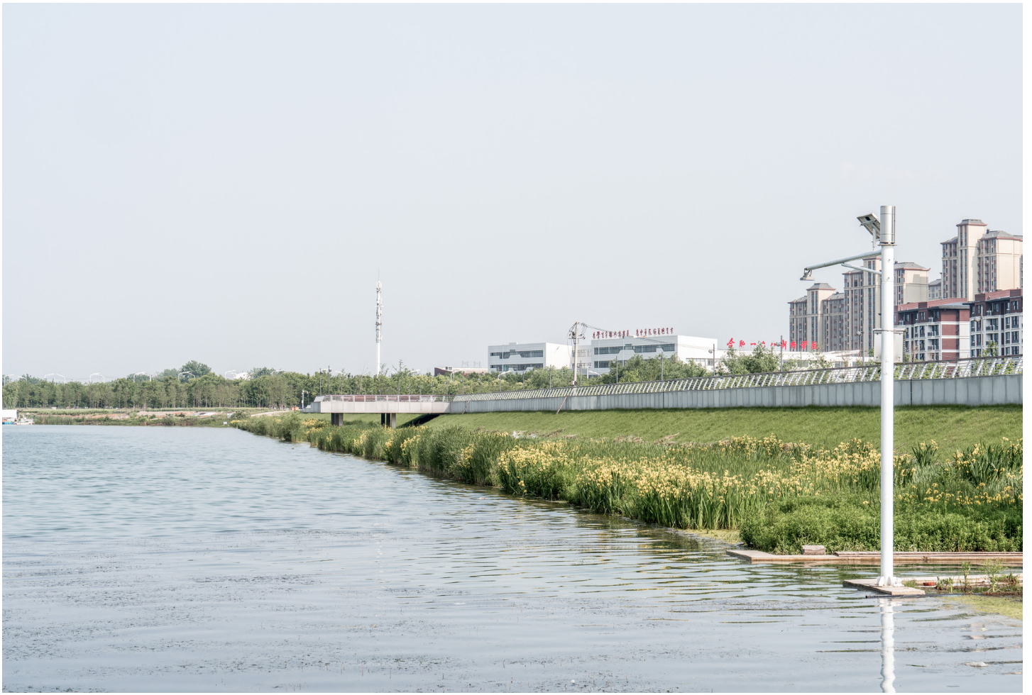
Revitalisiertes Talsperrenufer mit Schutzmauer und Öko-Berme
